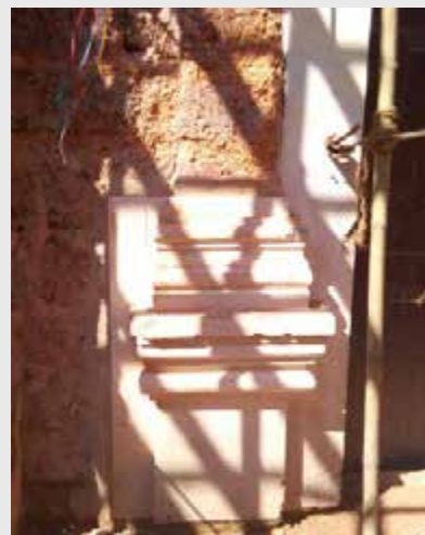
Lime plaster sampling at 'Panha de Franca', Goa
